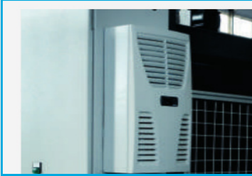
Elektrik Kabini Soğutma Sistemi
